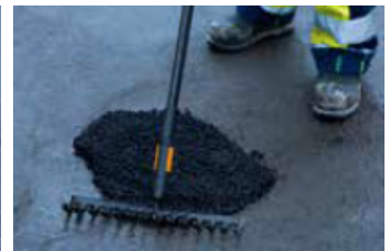
4. Jämna till överflödigt asfaltsblandning.
