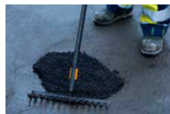
4. Jämna till överflödigt asfaltsblandning.
