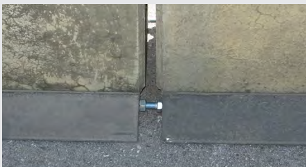
JUSTERAD SPÄNNBULT
